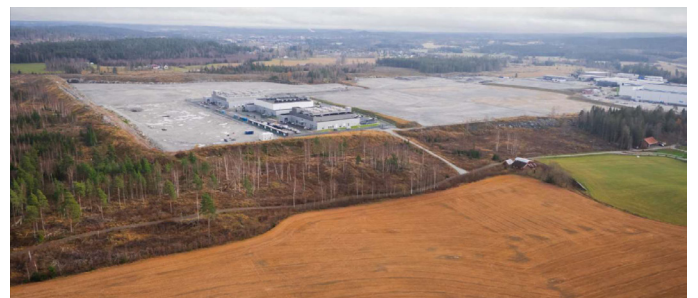
Nordvestre del av Holtskogen næringsområde (felt N5A-B med Stack datasenter) med tilliggende jordvoller i nord, sett fra nordvest (over gårdstunet ved Berg gård)
