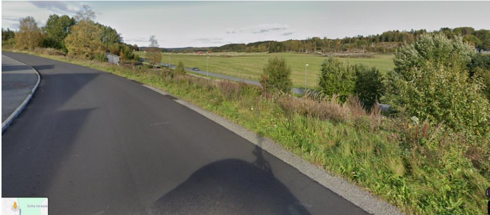
Figur 6 Utsyn fra sydvest. Ødegårdveien har et lavpunkt ganske langt syd i bildet som leder overvann fra overliggende områder inn på tomte og ned mot Langnesveien. Fortau fungerer til en viss grad som fordrøyning før det renner over veien. (Google)
