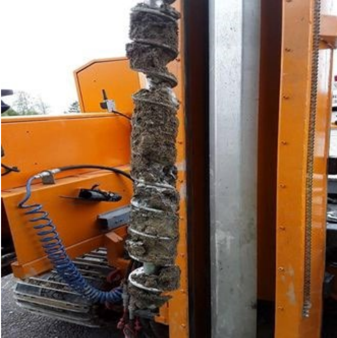
M19 0,5-1 meter, overgang til silt ved 0,5 m
