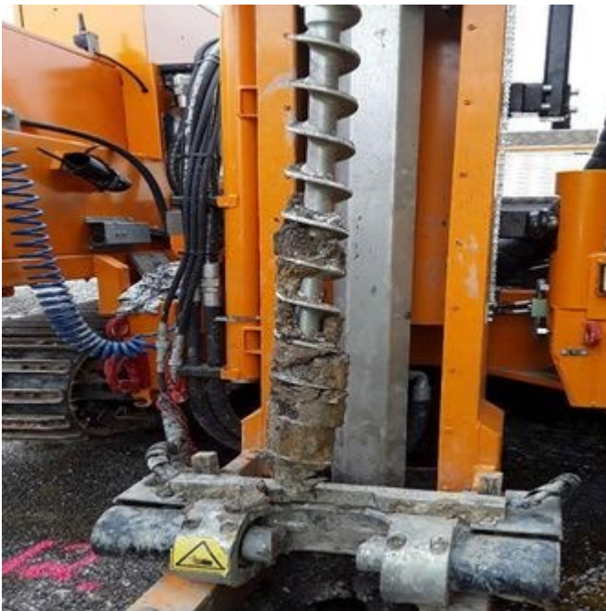
M16 0,5-1 meter. Asfalt og grus i topp.
