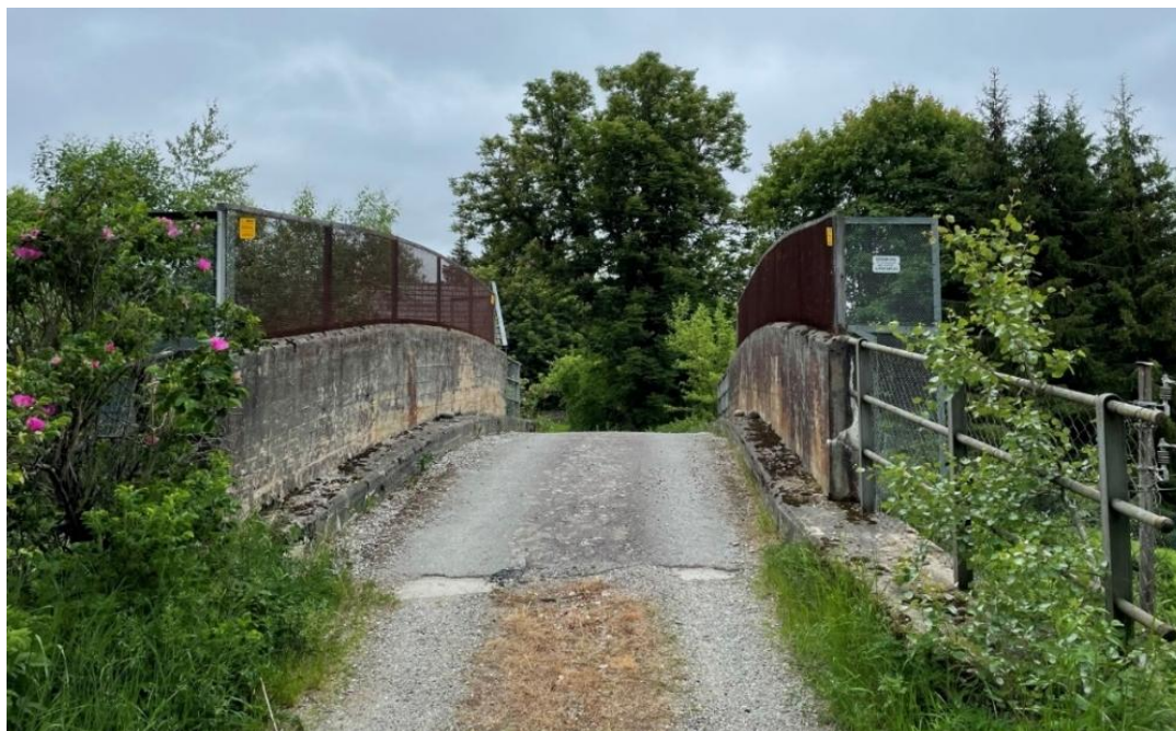
Figur 24: Overgangsbrua som krysser jernbanen vest i planområdet. Denne brua planlegges revet.
