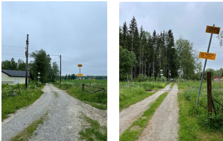
Figur 26: Bildene viser de to usikrede planovergangene i planområdet. Bingen til venstre, Stubberud til høyre.
