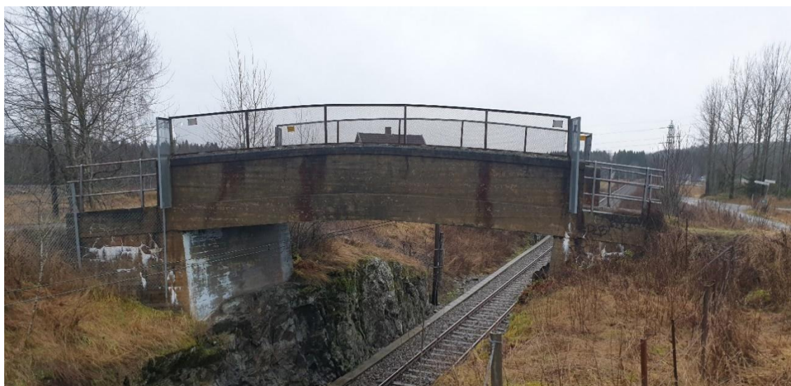
Figur 25: Bildet viser brua som ligger ved Langnesveien, midt i planområdet. Det planlegges at denne erstattes med ny bru.
