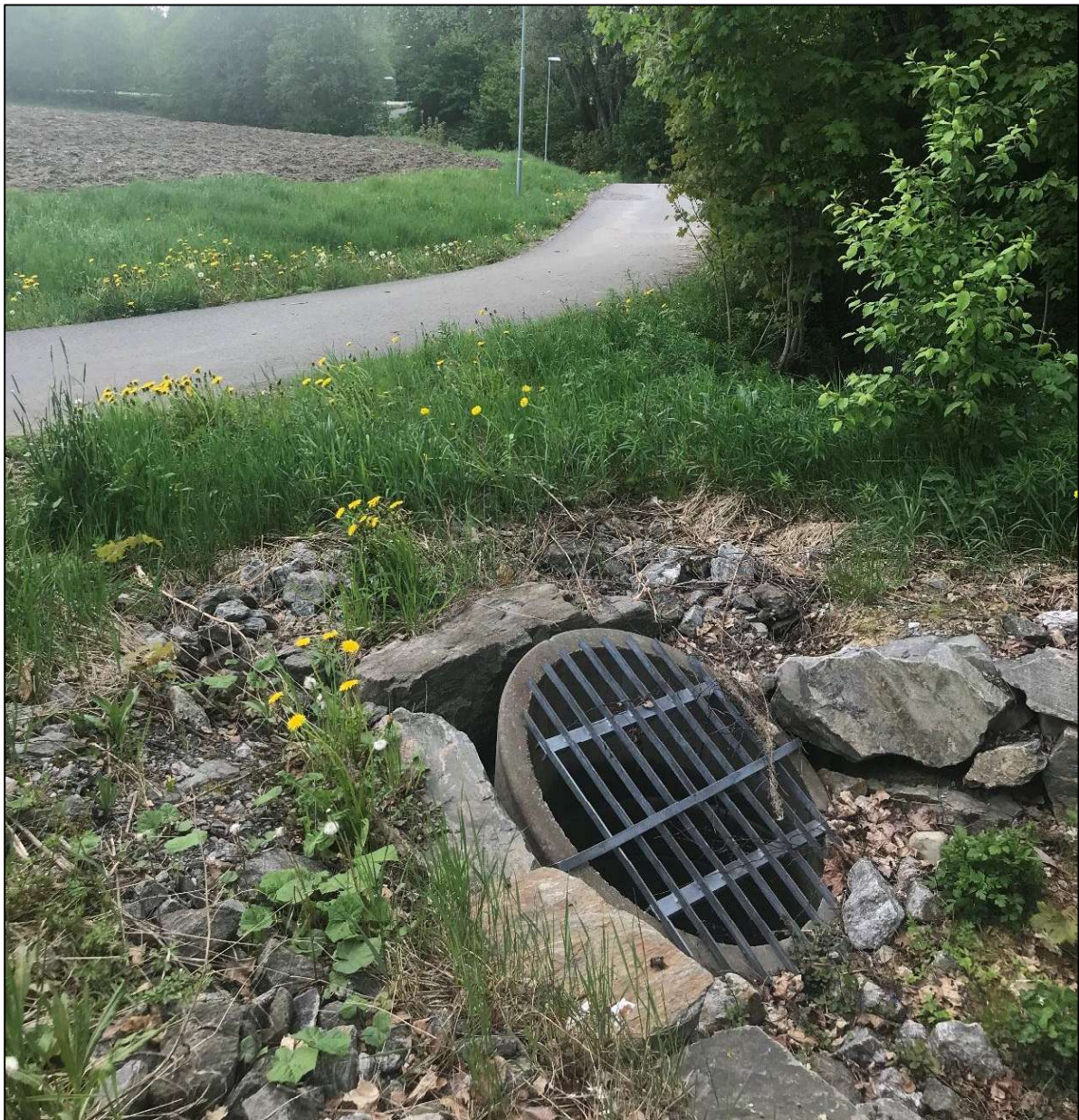
Figur 34: Bekken går i rør nordvest for planområdet, sett fra gang- og sykkelstien retning Askimveien.
