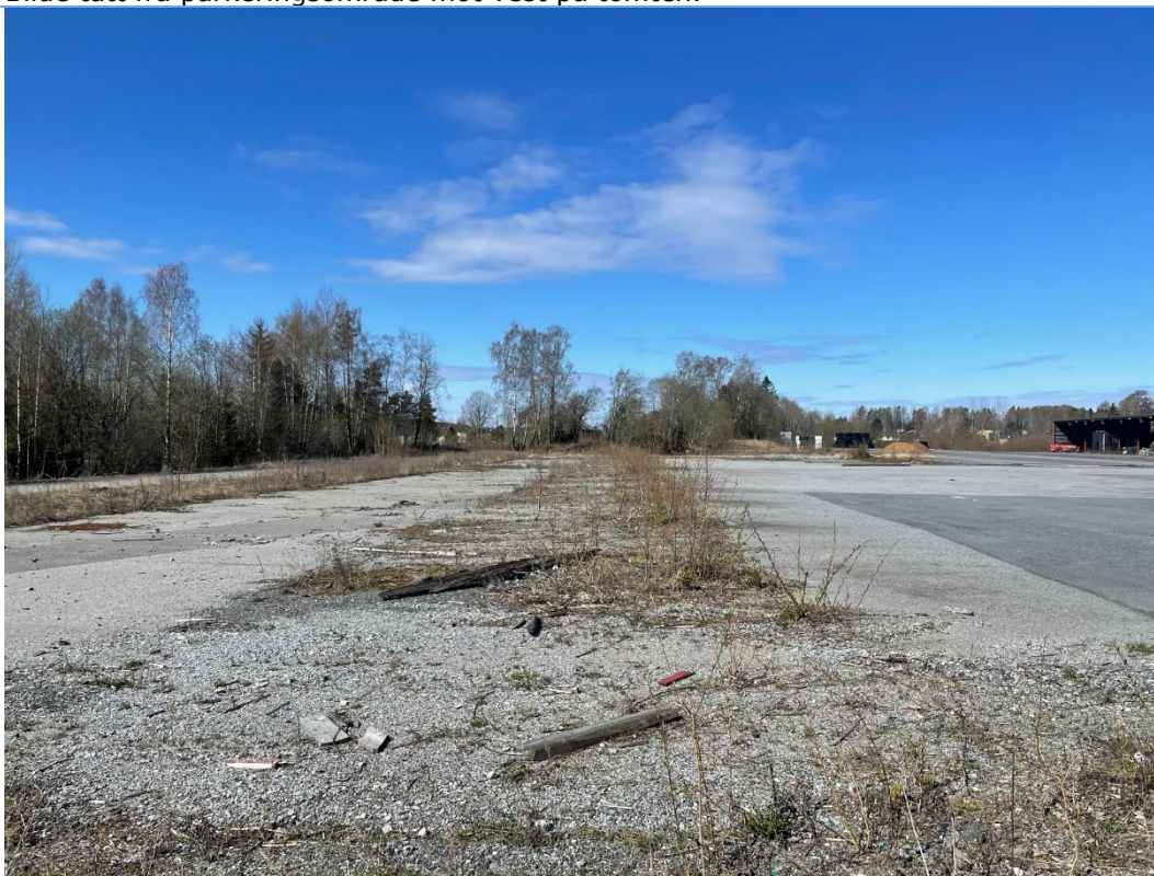
Revet bygninger og innfylte områder sør-vest på tomten.
