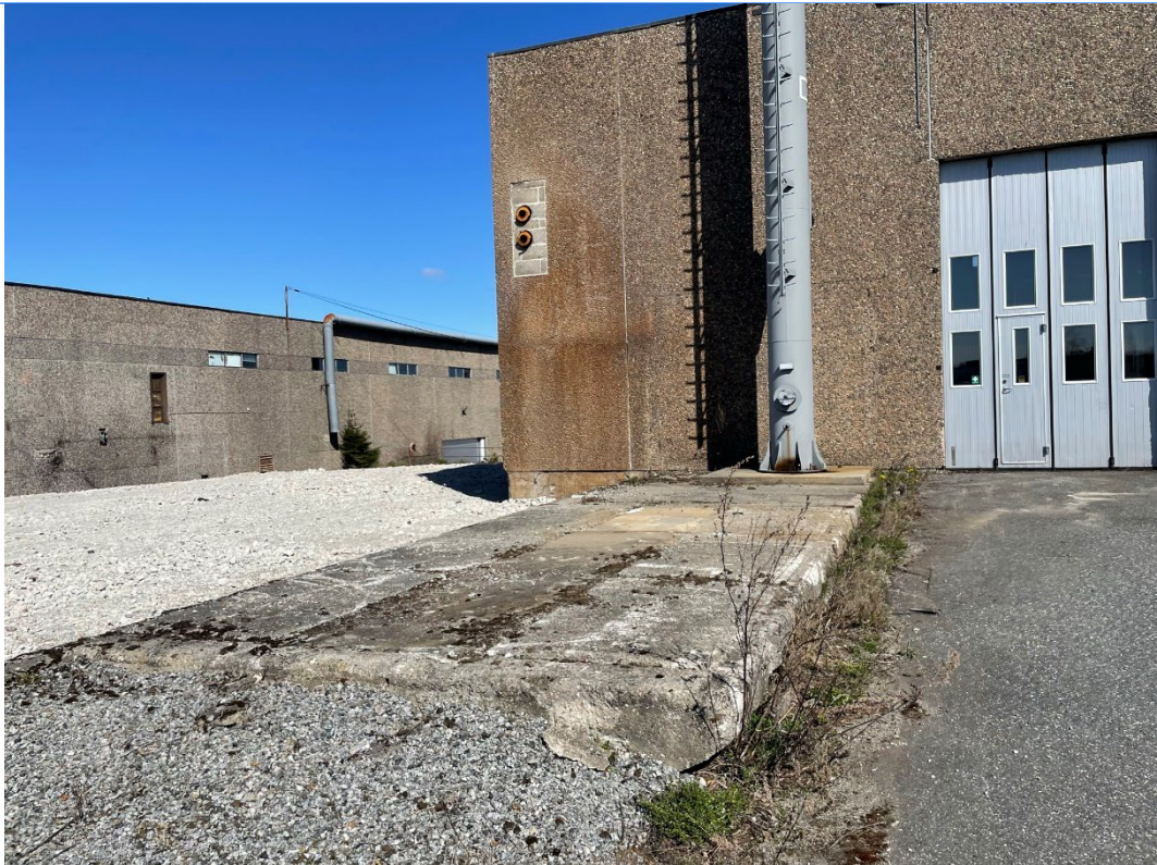
Betongdekke hvor tidligere tank var plassert.
