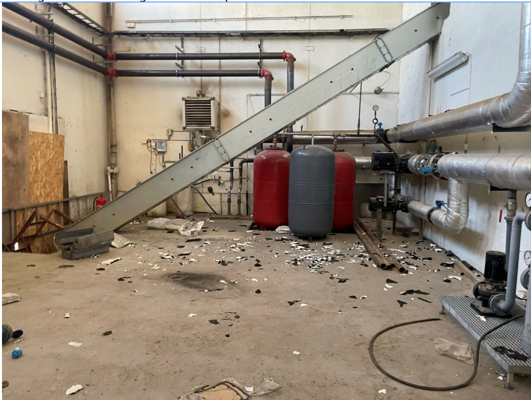
Innsiden av område tidligere benyttet til produksjon.
