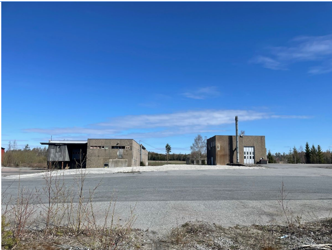
Gjenstående bygg midt på området. Utfylt område og ny asfalt hvor det tidligere var basseng og dieseltank.
