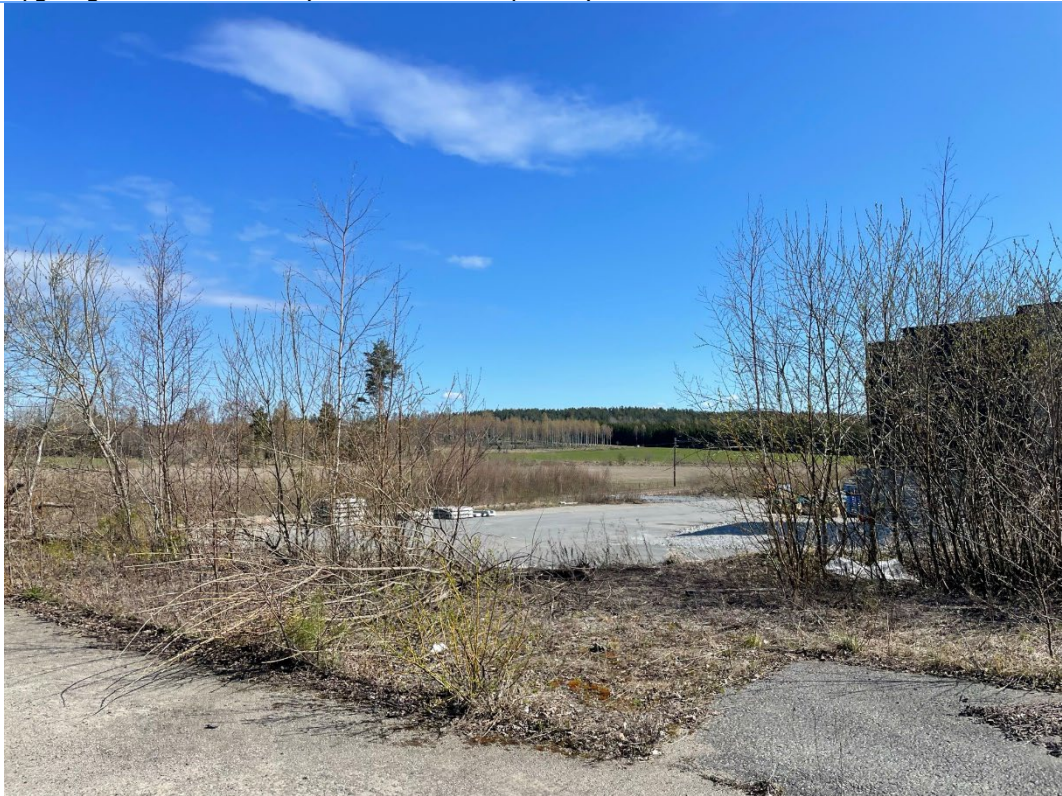
Bilde er tatt mot bakside (nord) av paraplytaket, mot jernbaneskinnene.
