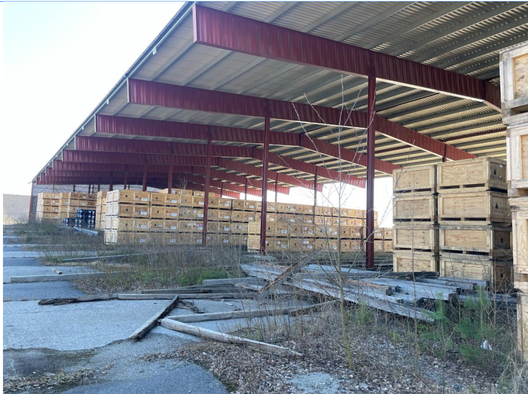
Paraplytak, hvor det er utleid lagringsplass.
