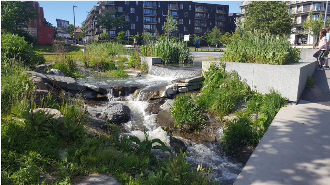
Figur 1: Overvannshåndtering på Ensjø i Oslo (foto: Nils Petter Nicolaysen)
