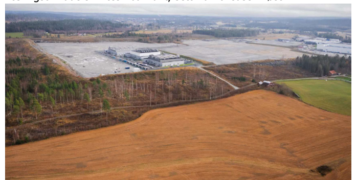
Nordvestre del av Holtskogen næringsområde (felt N5A-B med Stack datasenter) med tilliggende jordvoller i nord, sett fra nordvest (over gårdstunet ved Berg gård)
