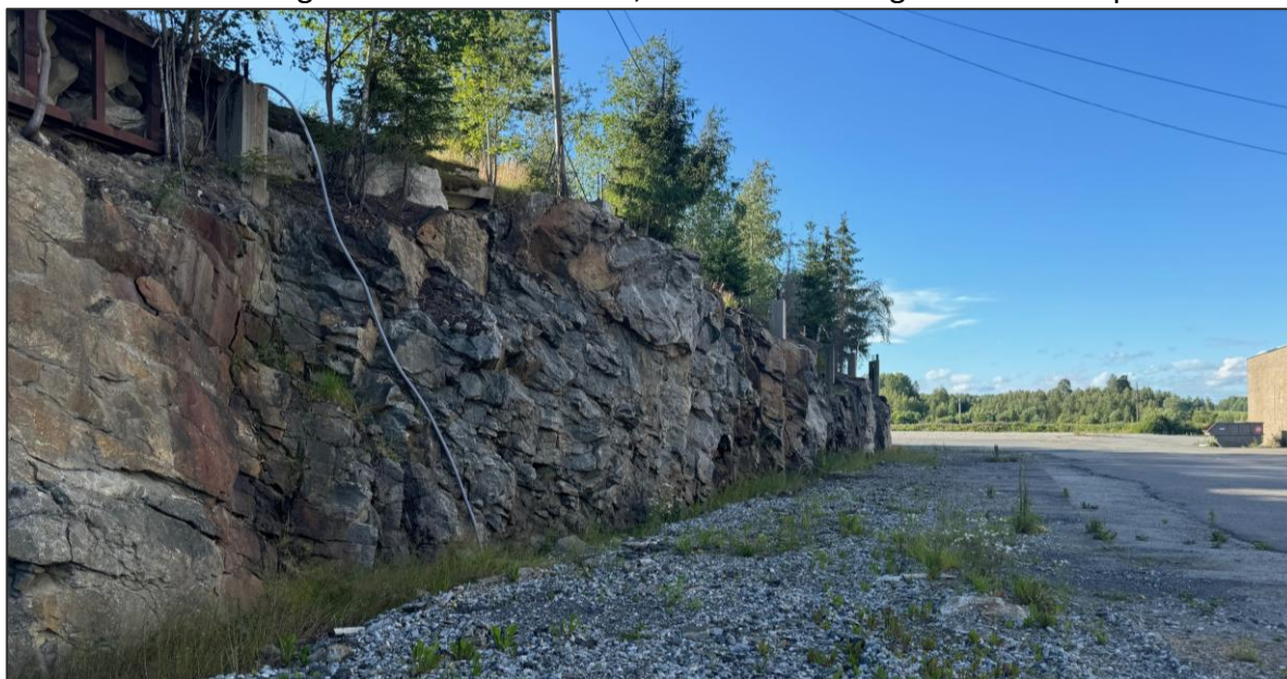
Figur 8 Sprengt ut fjellskjæring. Bilde er tatt sommeren 2024.
