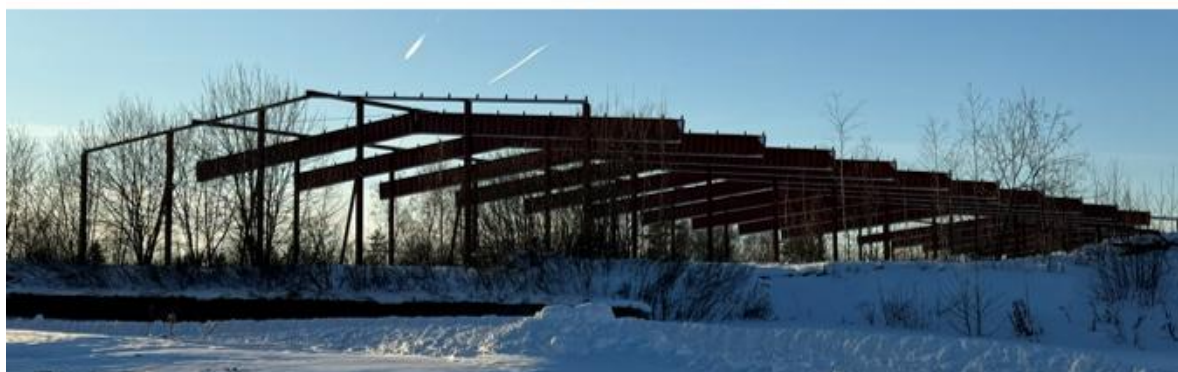
Figur 5 Bilder fra befaring januar 2023.
