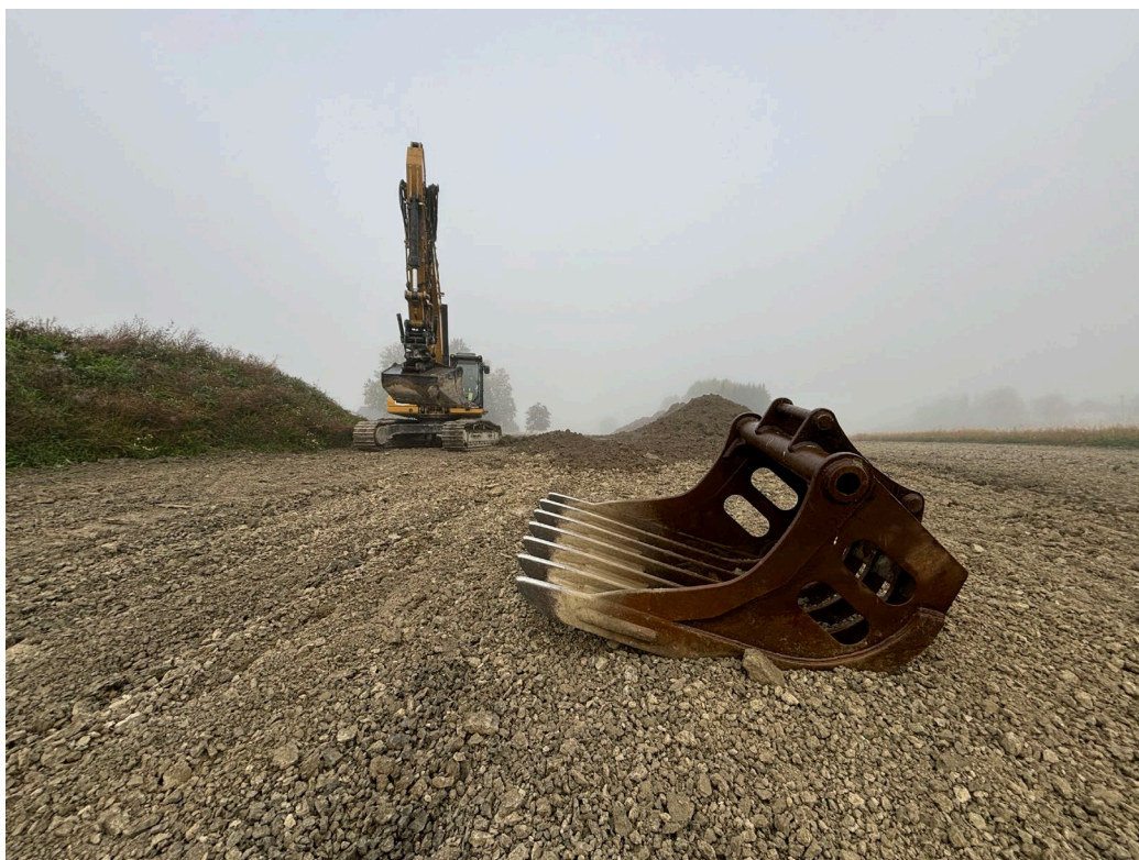
Figur 10 Bildet viser jordløsning av B-sjiktet og tilbakelegging av A-sjikt på NRVA PV2 E2 Løkenflaen. Det ble benyttet beltegående gravemaskin og nydyrkingsskuffe. (Foto: Monica Jayesingha).
