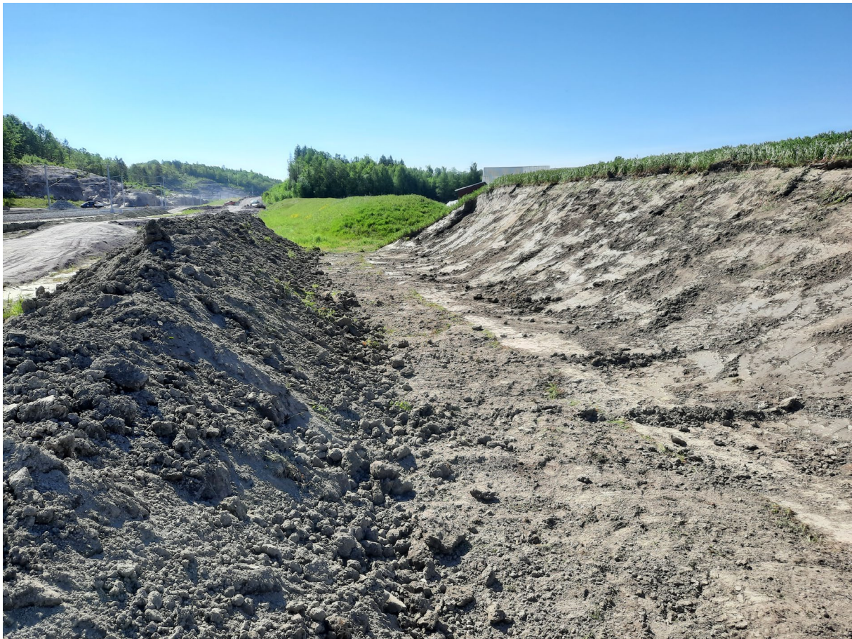
Figur 11 Bildet viser deling av en ranke på langs for tørking før utlegging. (Foto: Trond Knapp Haraldsen)
