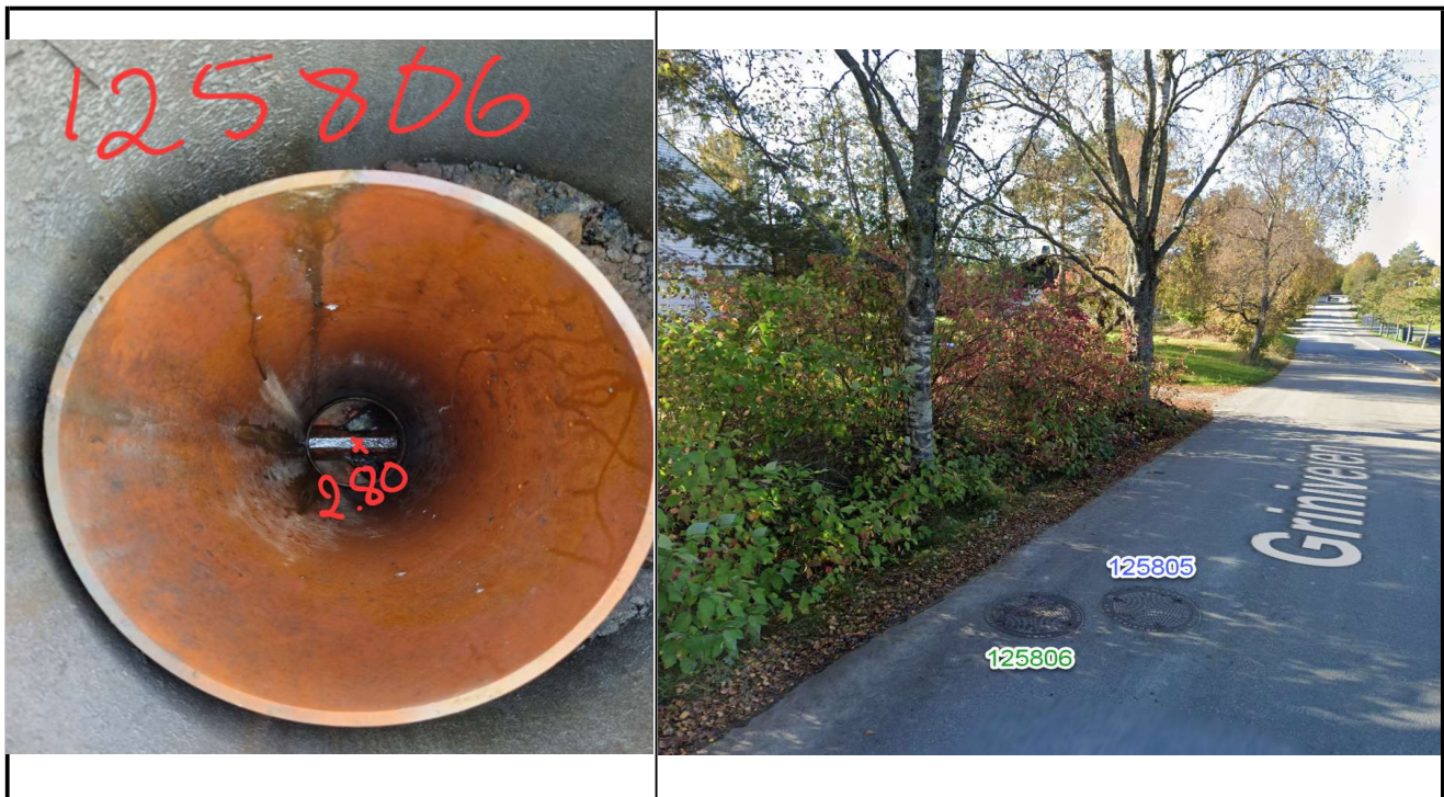
Bilde orientert mot nord
