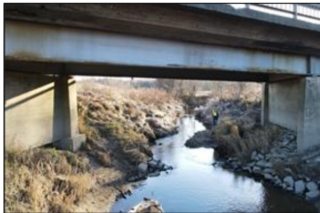
Figur 8-2 Eksisterende plastring under bru.
