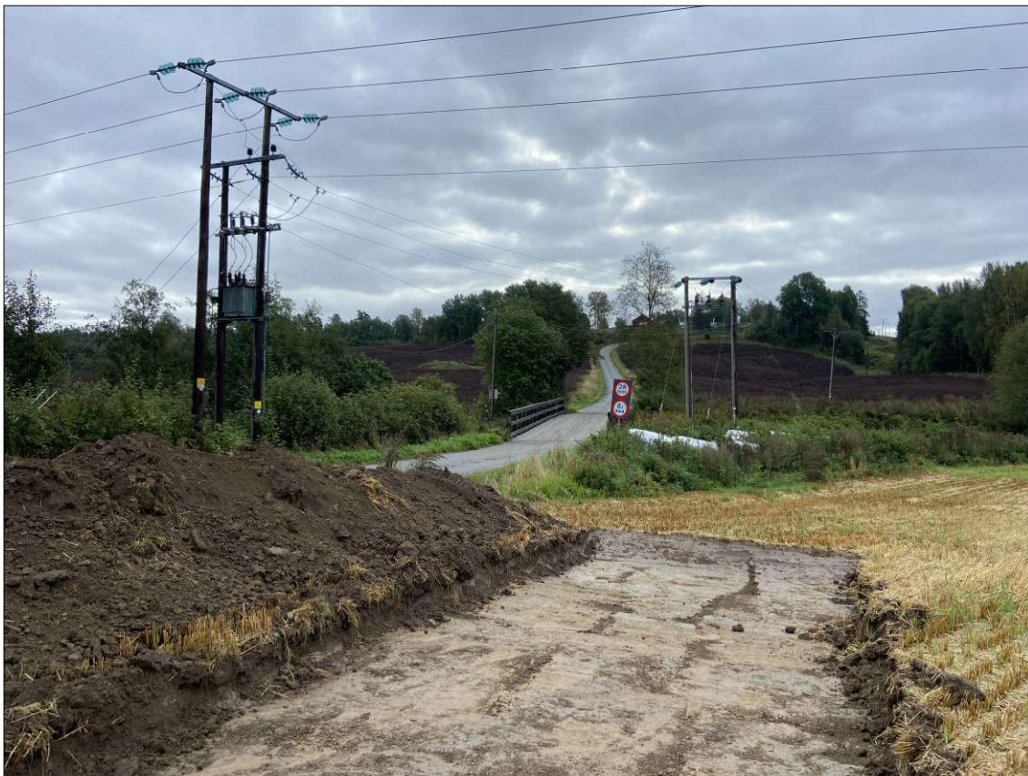
Brua sett frå austre ende av vestre sjakt sør for veg. Sett mot aust.
