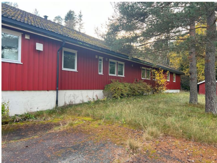
Figur 5: Nordsiden av dagens bygningsmasse
