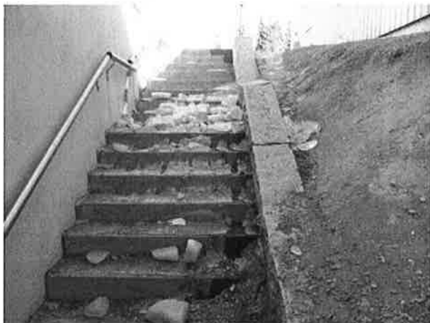
B01 Frostskader.
