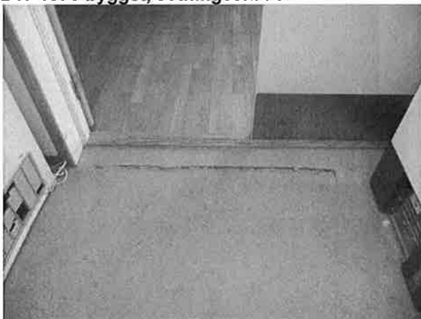
B17 1970 bygget, setningsskade.
