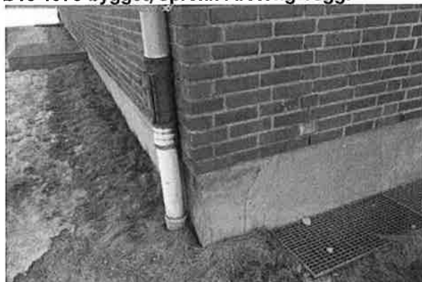
B15 1973 bygget, sprekk i betong-vegg.
