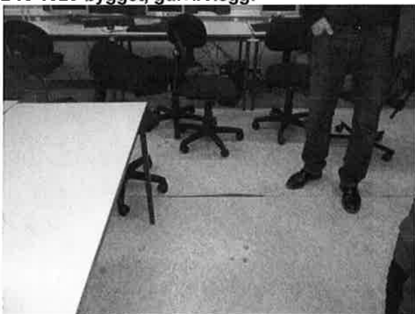
B17 1970 bygget, setningsskade.
