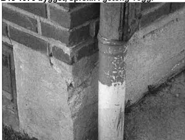
B15 1973 bygget, sprekk i betong-vegg.
