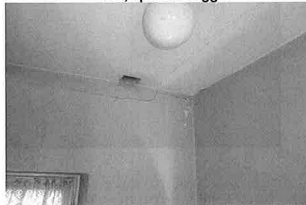
B16 Rom A213 WC, sprekk i vegg.
