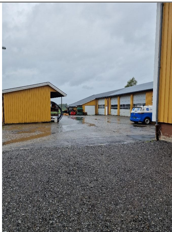
Figur 5 viser plassen mellom de to lagerbygningene. Lagerbygget til høyre er en del av hovedbygget.
