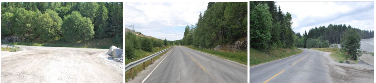
Foto fra 2018 viser eksisterende avkjørsel ved til steinbruddet, med gode siktforhold mot nord og sør langs Fv 122.
