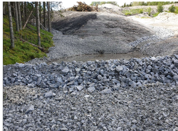
Fordrøynings-/sedimenteringsdam i østre og sørøstre del av området, som hindrer direkte avrenning til Rudbekken.
