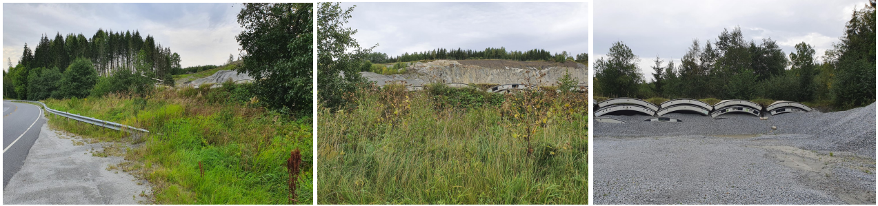
Bildene viser ny og høyere kombinert voll/skjerm langs østre del av driftsområdet som gradvis gror til, samt oppbygning mot virksomhetsområdet med betongelementer.
