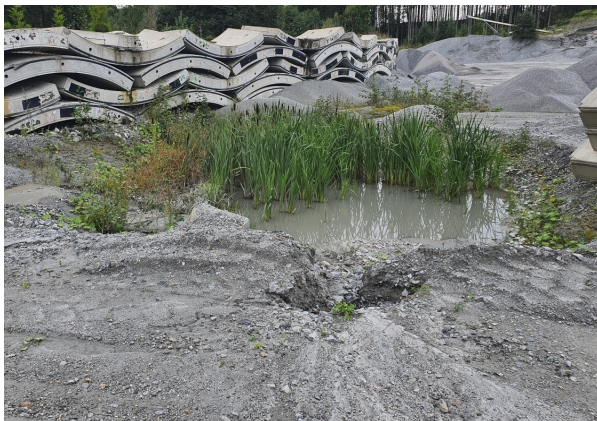
Fordrøynings-/sedimenteringsdam i østre og sørøstre del av området, som hindrer direkte avrenning til Rudbekken.
