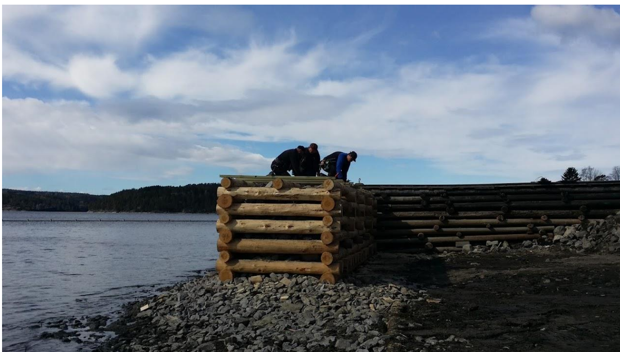
Restaurering av dampskipsbrygga på Sandstangen 2016
