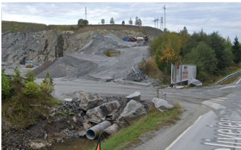
Figur 3-2: Overvannsrørene langs avkjørselen ved steinbruddet.
