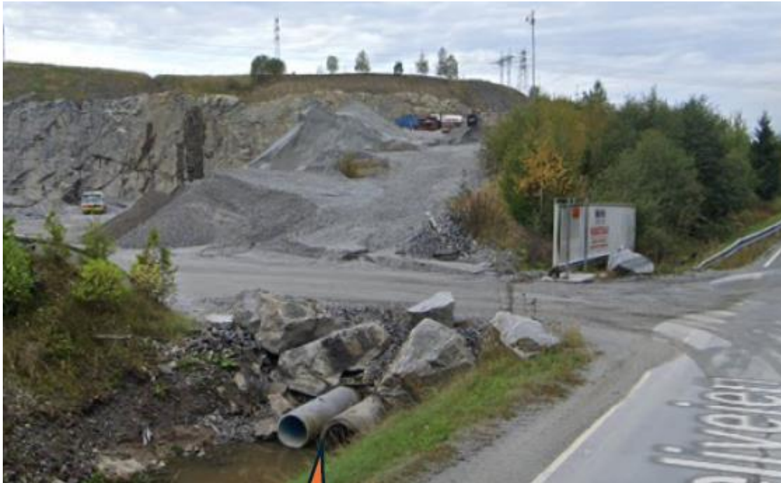
Figur 3-2: Overvannsrørene langs avkjørselen ved steinbruddet.
