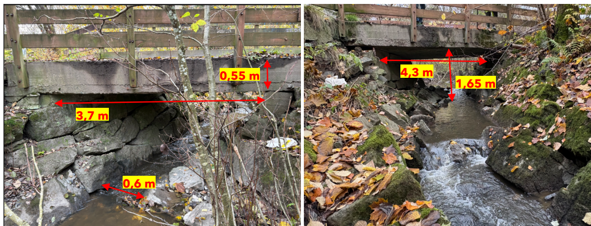
Figur 3-4. Bilder tatt av bru under turvei. Venstre: tatt mot innløpet. Høyre: tatt mot utløpet.
