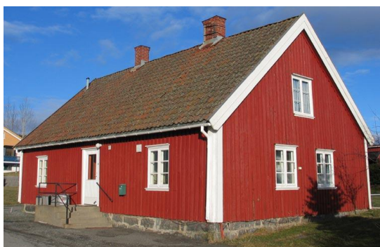
Arbeiderbolig i Kykkelsrud
