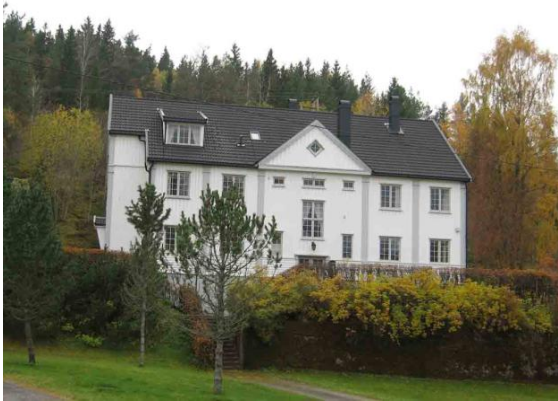
Solbergfoss kraftstasjon, administrasjonsbygget
