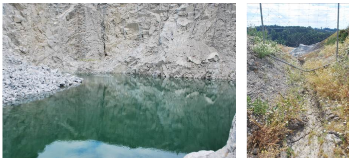
Oppsamlingsdam i nordre del av uttaksområdet, samt avrenningsgrøft fra tiliggende jorde i nord gjennom anlagt voll.
