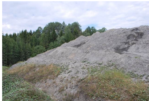
Mellomlagring for avdekningsmasser i søndre del av planområdet. Grøft hindrer avrenning til skogsområdet.
