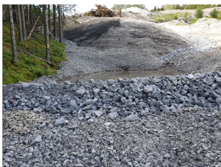
Fordrøynings-/sedimenterings-/fangdam i søndre del av uttaksområdet, som demmer opp tilsig fra grøft/renskemasser sør.
