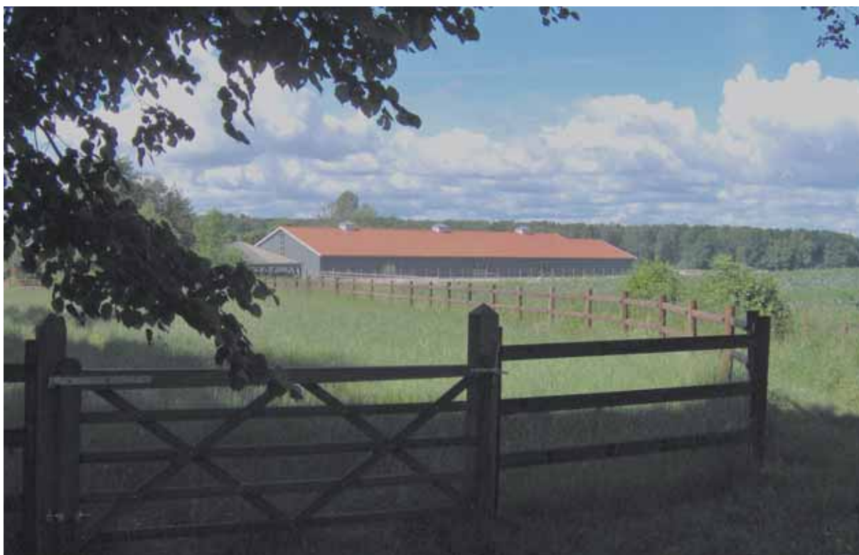
Ridesenteret er gitt et formspråk og materialbruk i bygninger og konstruksjoner som er godt tilpasset gård og omkringliggende landskap på tross av stor bygningsmasse. Her er brukt arkitektfaglig kompetanse for å få til en helhetlig og godt tilpasset løsning. Kubberød gård på Jeløy, Moss. Arkitekt: Hille Melbye Arkitekter as. Foto: Øyvind Nordberg
