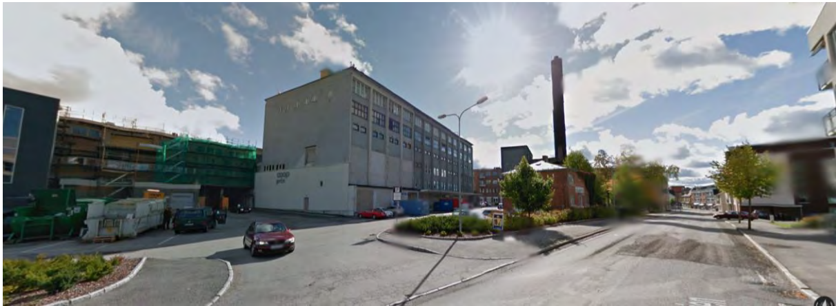
Bilde 2: Tatt mot sørlig retning, fyrhuset med pipa til høyre med gamle direktørbolig (bygg G foran).
