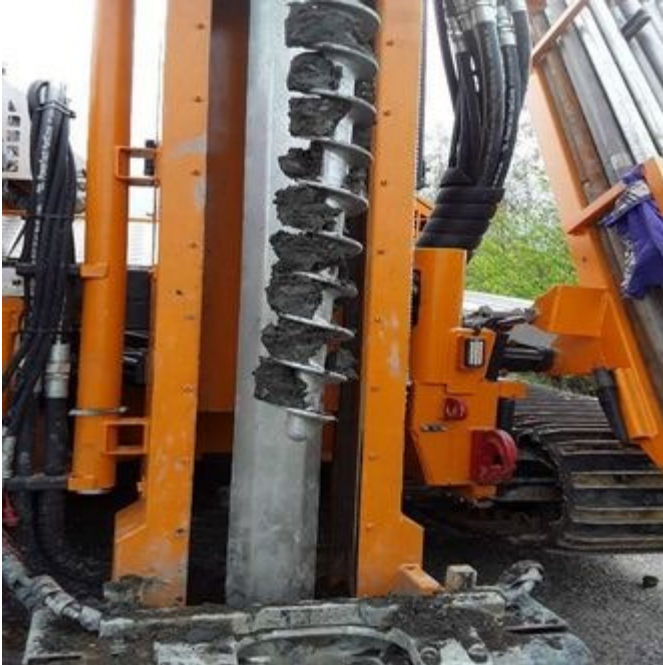
M20 1-2 m. Overgang til finere masse ved 1,8 m.
