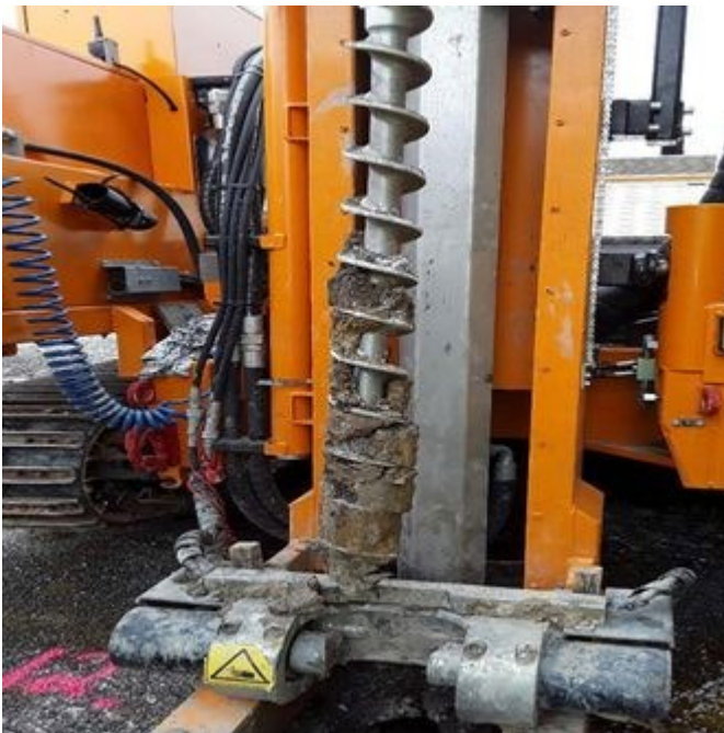
M16 0,5-1 meter. Asfalt og grus i topp.
