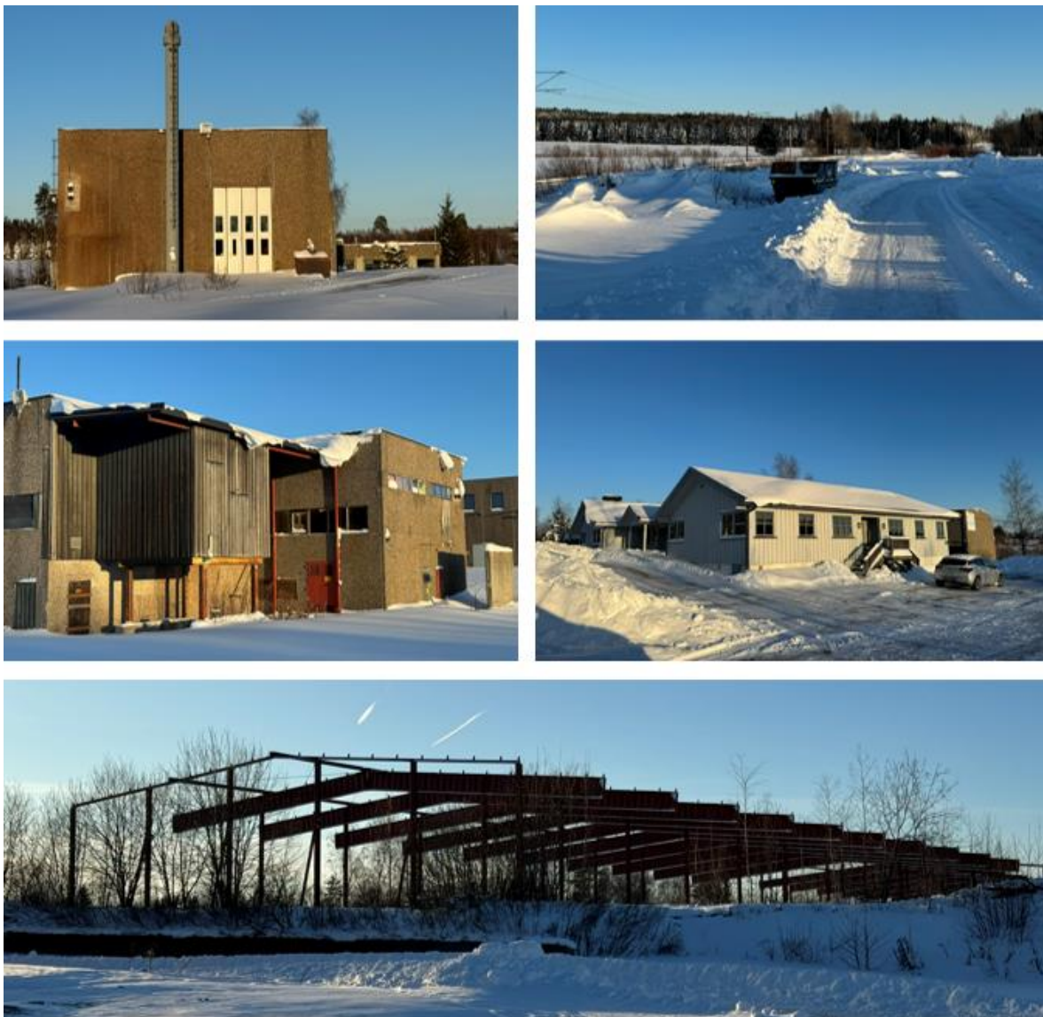
Figur 2 Bilder fra befaring januar 2023
