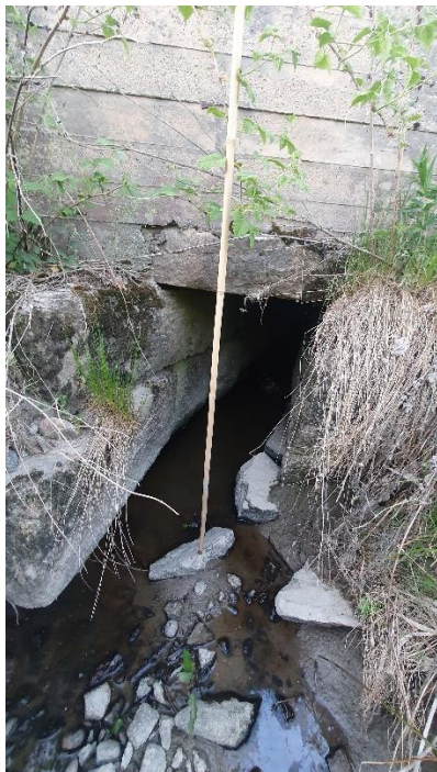
Figur 13 - bilder av kulvert under jernbanen
