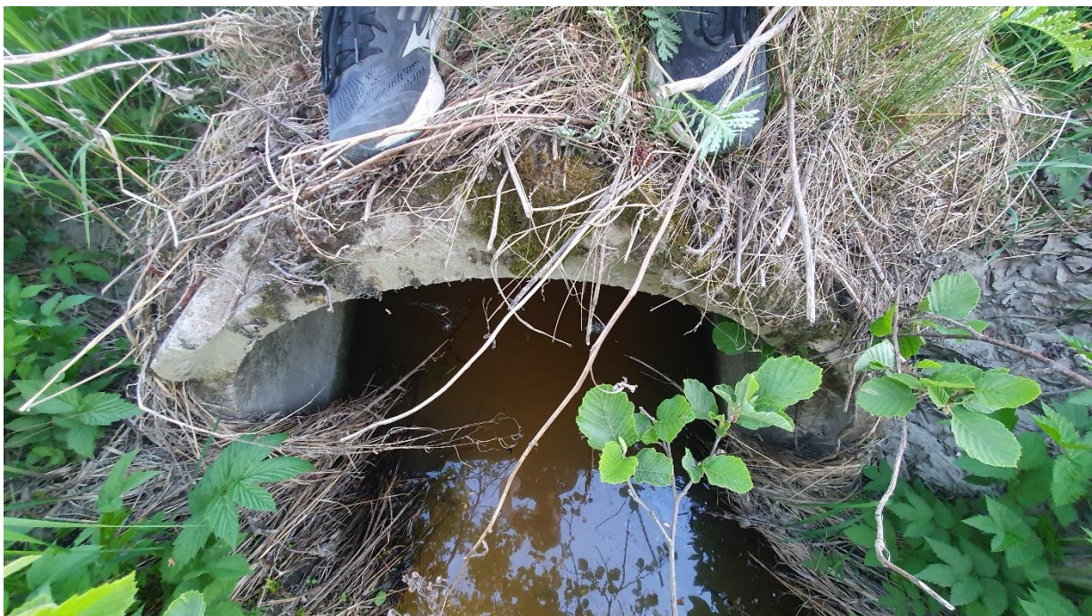
Figur 15 - Bilde (tatt IHK, 21.05.24) viser innløpssiden av kulvert under innkjøring
