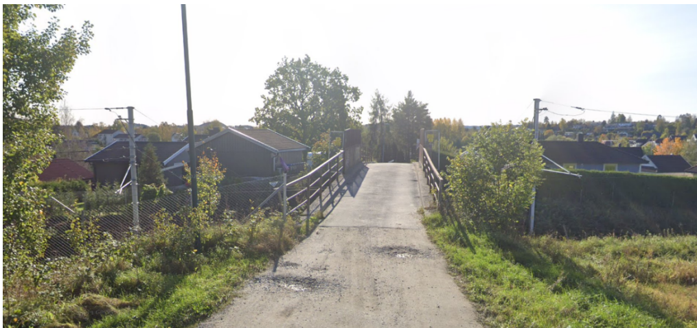
Figur 4-5: Jernbanekryssing i vest. Brua er sett fra nord. Bilde fra Google Street View oktober 2023
