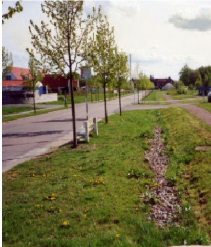
Figur 11: Illustrasjon av dreneringsgrøft hentet fra miljøblad 92. Bredde topp 1,5 m, dybde 1m, lengde 48 m, volum ca 50 m 3
