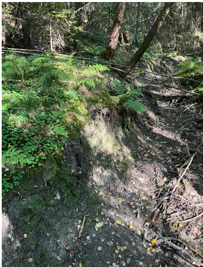
Figur 4.6 Bilde av erosjon i ravine 3.
