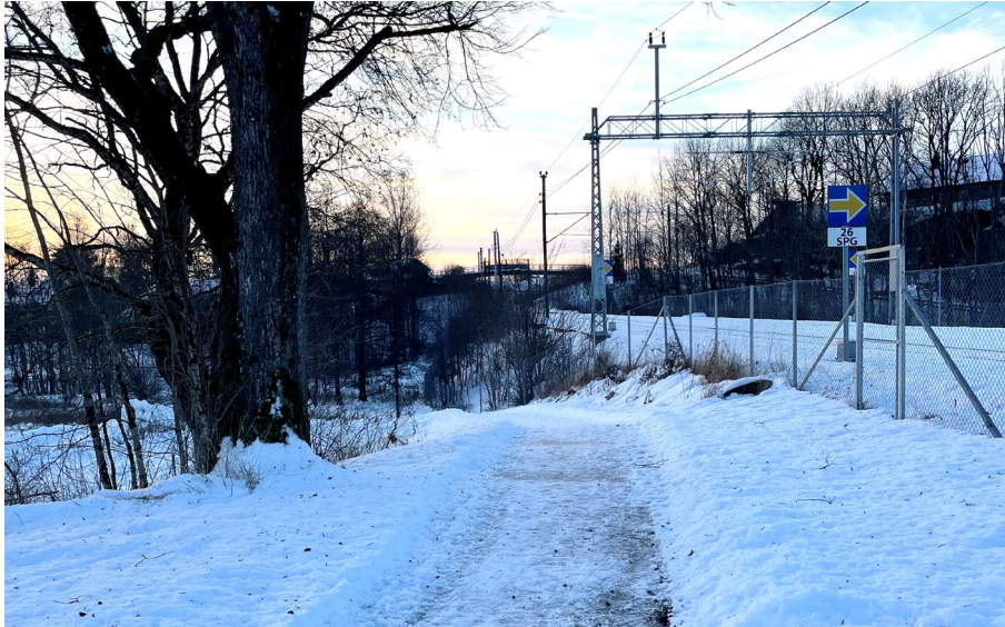
Figur 48 Gang- og sykkelforbindelsen mellom Spydeberg stasjon og Hyllibekken. Foto Mads Engh Juel, januar 2023.
