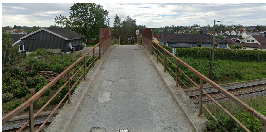
Figur 10 Hylliveien bro. Bilde tatt mot sør. Kilde Google streetview.
