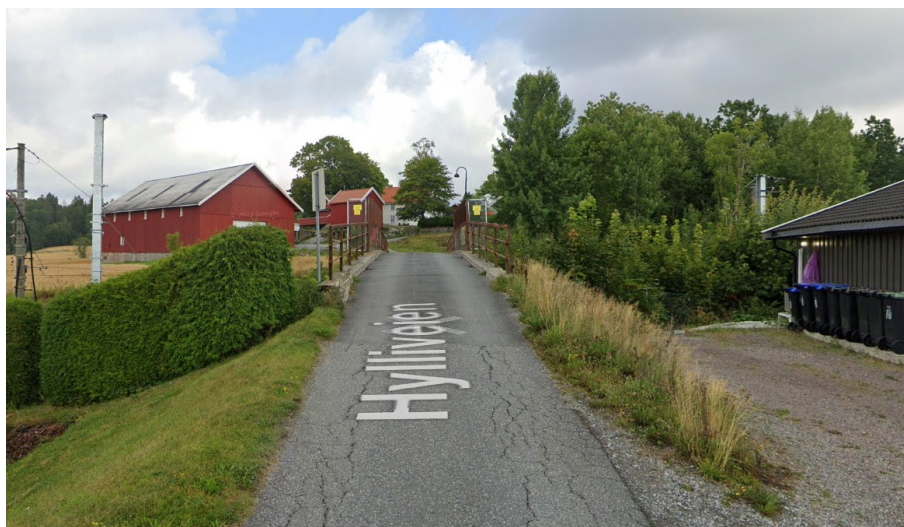
Figur 9 Bro over jernbanelinje over Hylliveien. Bilde tatt mot nord. Kilde Google streetview.
