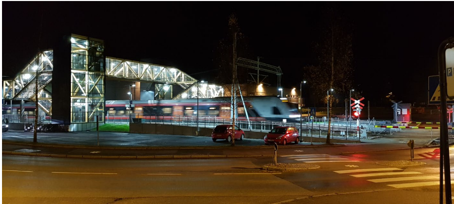
Figur 12 Trappehus og plankryssing ved Spydeberg stasjon. Foto: Rune Opheim
