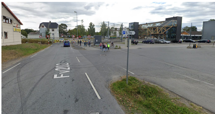
Figur 71 Planovergangen sett mot syd (fra skolen), med bomanlegget nede og tog på plattformen. Kilde: Google streetview september 2021
