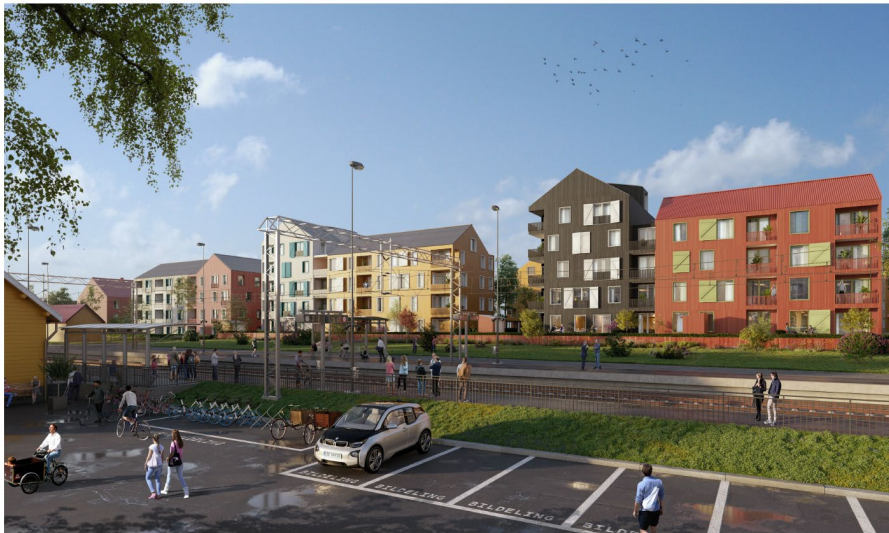
Figur 54 bebyggelsen sett fra stasjonsområdet. III: Pushak AS
