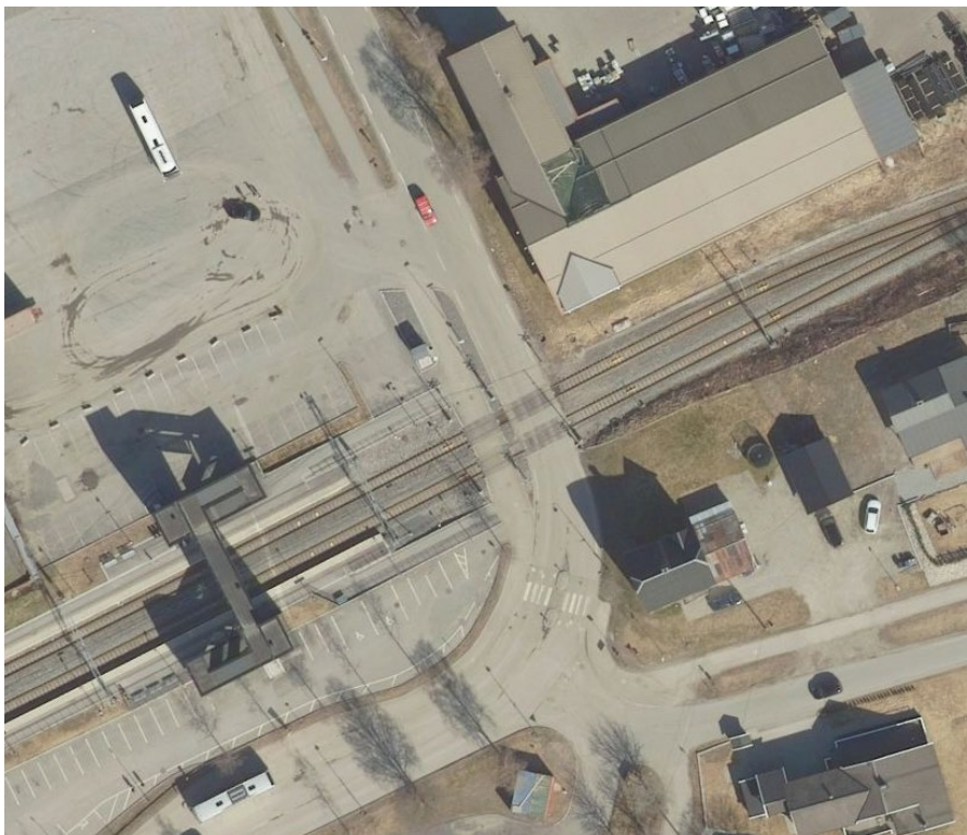
Figur 67 Luftfoto av planovergangen. Kilde: norgeskart.no
