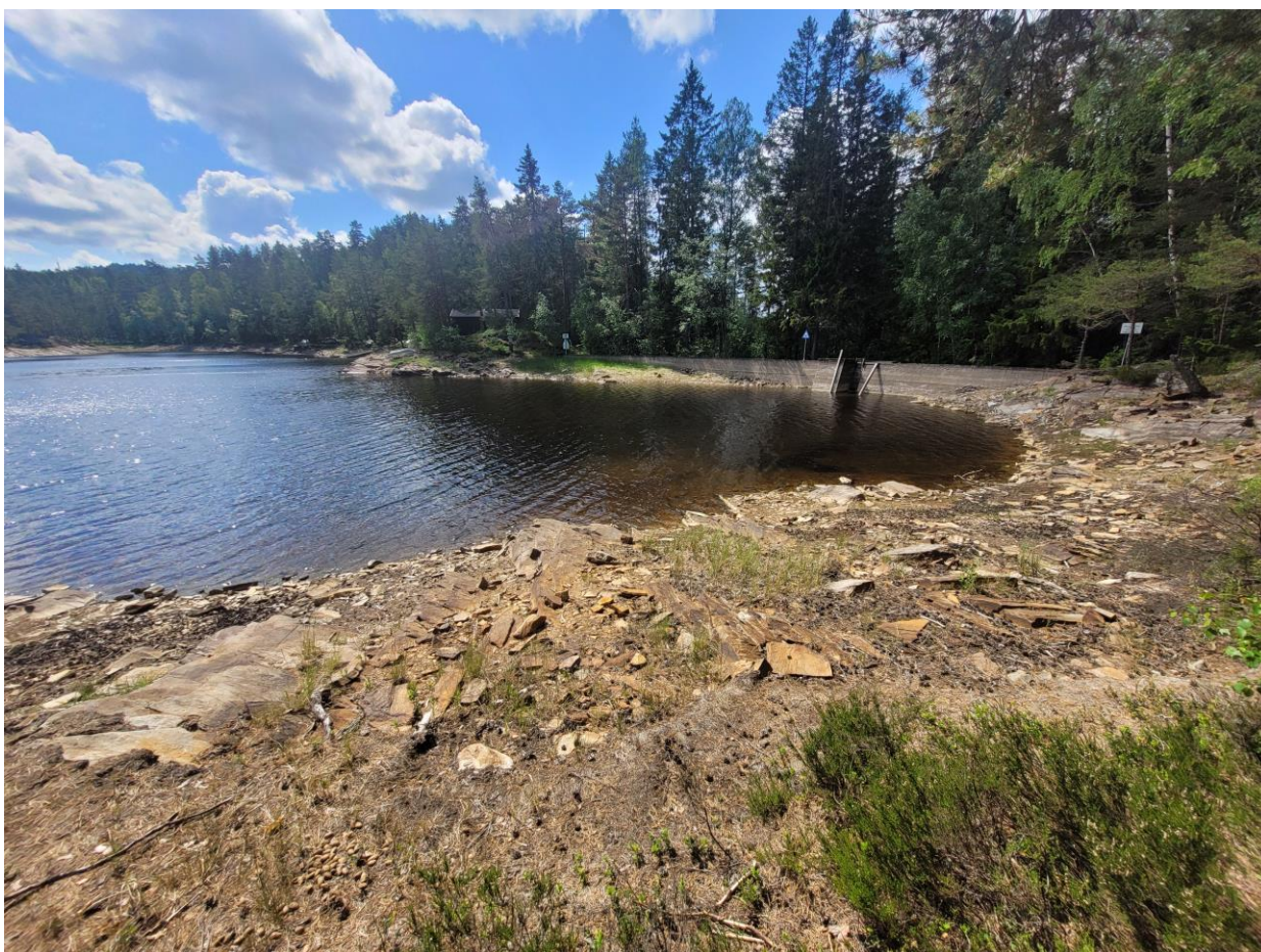
Figur 1-1: Foto viser demning ved utløp av Måstادتjern. Vannet var allerede kraftig nedtappet ved befaringstidspunktet 6. juni 2024 og under feltarbeidet i slutten av august. Foto: Sweco.
