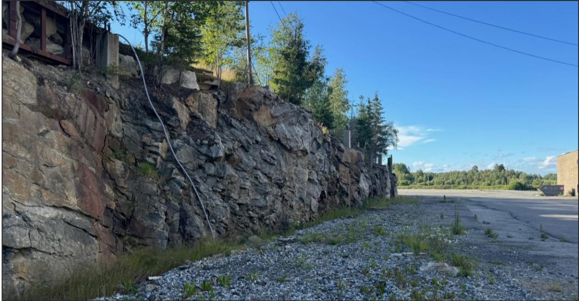
Figur 8 Sprengt ut fjellskjæring. Bilde er tatt sommeren 2024.
