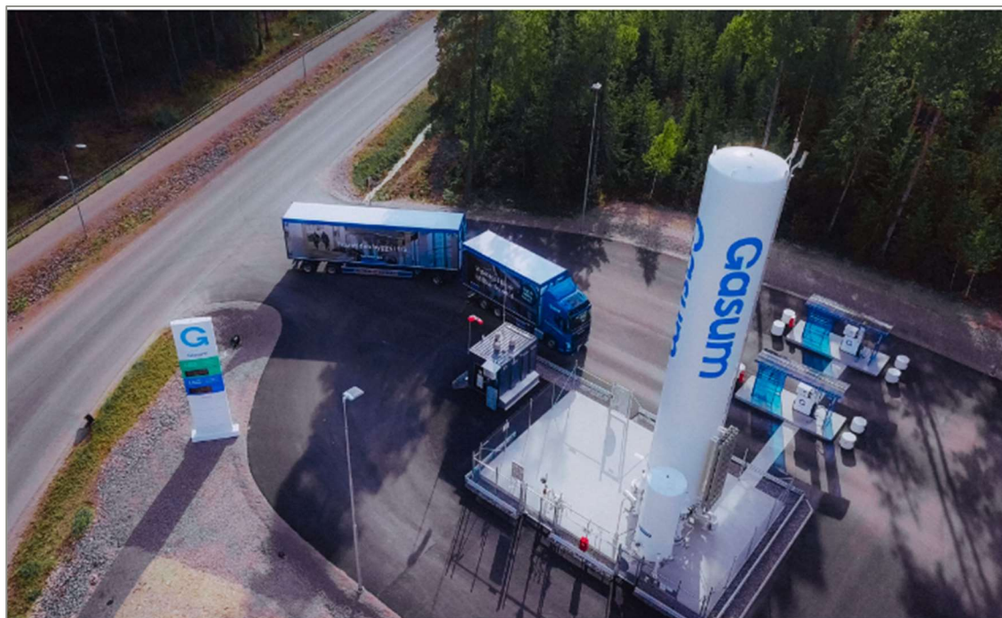
Foto av lignende gassanlegg for tungtransport (Kilde: biogassbransjen.no)
