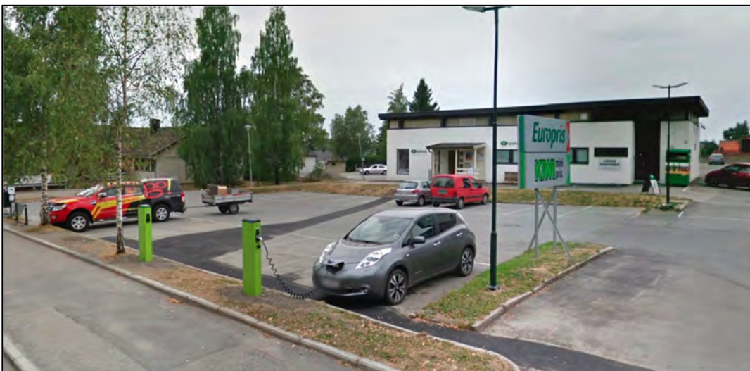
Figur 4: Telesentral og parkering (sett fra Stasjonsgata).
